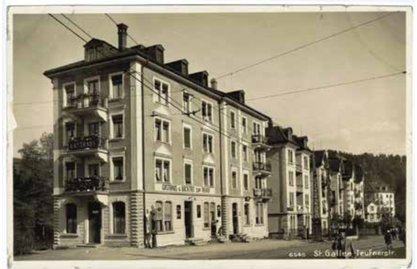
Nach 1931: Gasthaus & Bäckerei zum Talhof (an der Ecke mit Shell-Zapfsäule!). Im hinteren Teil des Hauses Teufener Strasse 143 war das Postlokal, Eingang bei der 3. Treppe. Durch das Fenster rechts wurde die Post angeliefert, oberhalb ist die Tafel Post Riethüsli zu erkennen. StadtASG
