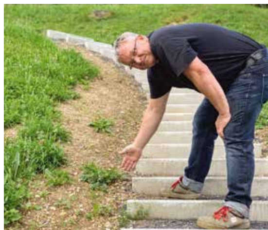
Hanspeter Speck auf den Stufen, sie sind 1 Meter breit und 18 Zentimeter hoch und die Trittpläche ist mindestens 30 Zentimeter breit, was ein gefahrloses und bequemes Benutzen ermöglicht.
